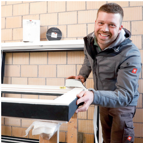
Lors du montage des fenêtres, Ueli Zihlmann travaille régulièrement avec la bande d'étanchéité multifonctionnelle Permafix 446.
