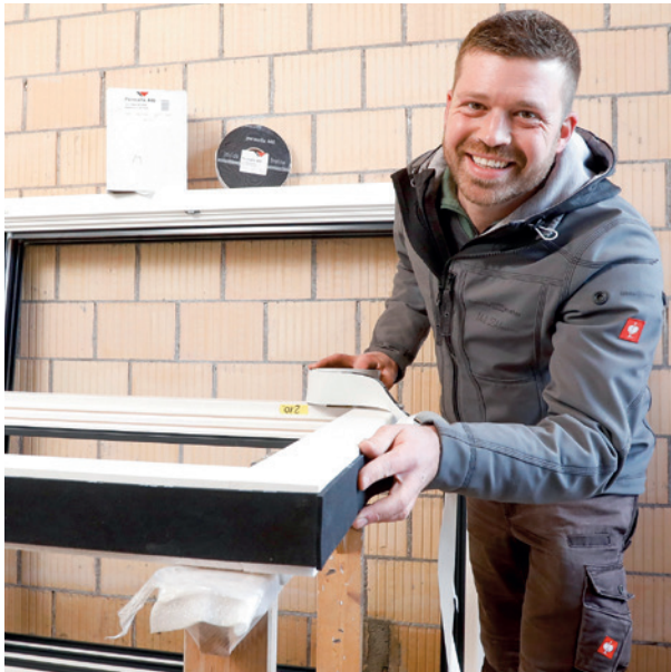
Bei der Fenstermontage arbeitet Ueli Zihlmann regelmässig mit dem multifunktionalen Dichtband Permafix 446.
