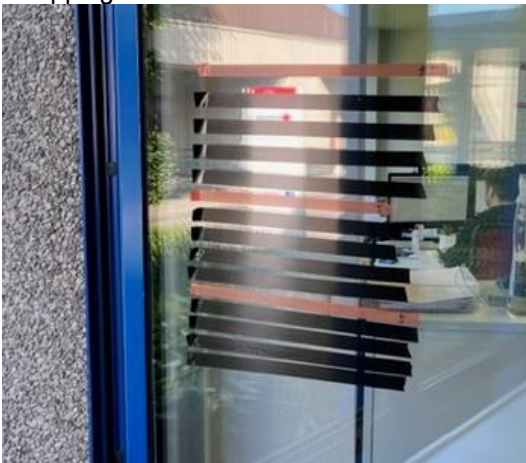
Strappingband auf der Aussenseite einer Fensterscheibe
